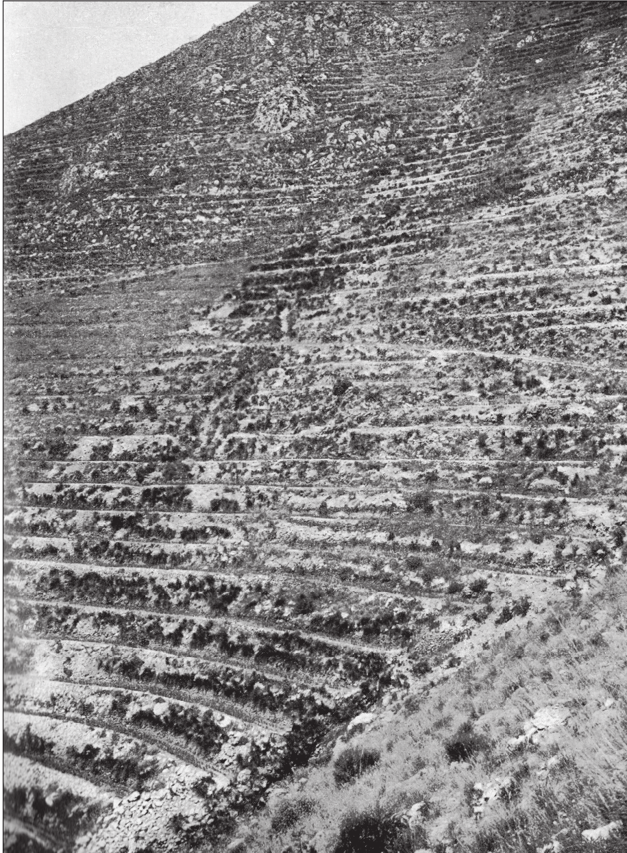
Fig. 6 — Una imponente opera di gradonamento effettuato nella Valle dell'Oreto. La didascalia recita: "Bacino montano di Pioppo. «Bacino Oreto». Sistemazione a gradoni e rimboscimento a semina" (Da VOCE, 1953). / An impressive stepping stone work carried out in the Oreto Valley. The caption reads: "Bacino montano di Pioppo. «Bacino Oreto». Sistemazione a gradoni e rimboscimento a semina" (after VOCE, 1953).
