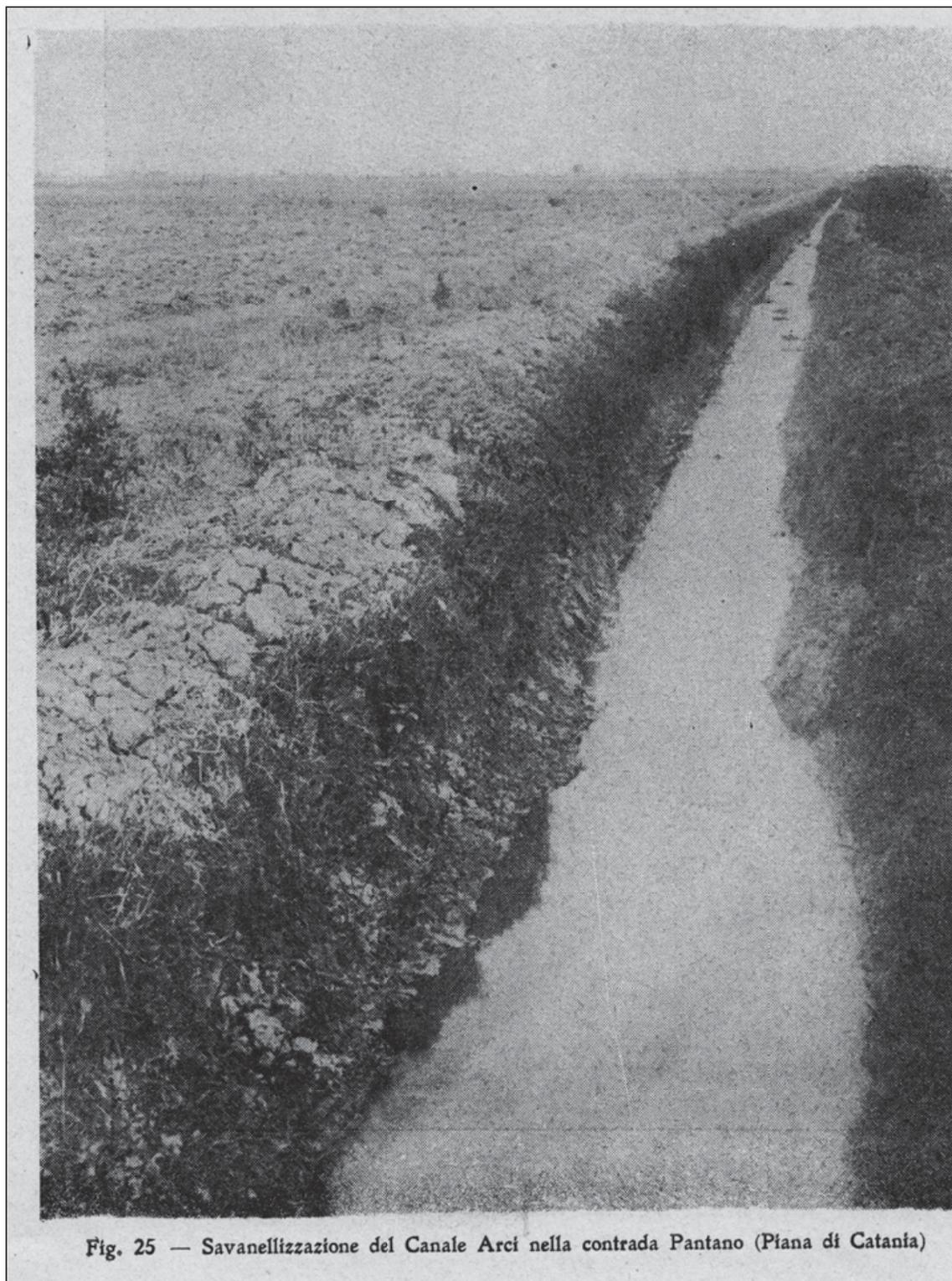
*Fig. 9 — Gli interventi di bonifica prevedevano spesso lo scavo di profondi canali di drenaggio (chiamati “savanelle”), come quello realizzato per bonificare il Pantano d’Arci nella Piana di Catania (da CONSOLI, 1928)/Reclamation interventions often involved the digging deep drainage channels (called “savanelle”), such as the one carried out to reclaim the Pantano d’Arci in the Plain of Catania (after CONSOLI, 1928).*
